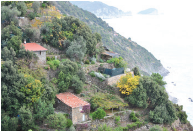
01 | Il paesaggio rurale scosceso sul mare costituito da terrazzamenti e case rurali in pietra. Sull'altro lato del versante si intravede la struttura di pannelli solari montati a terra Typical steep landscape on the sea, made of terraces and rural buildings. On the other side it is possible to see the steel structure of solar panels founded on the ground
