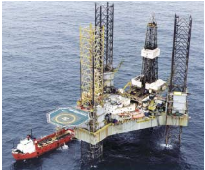
Bohrarbeiten in der deutschen Nordsee
