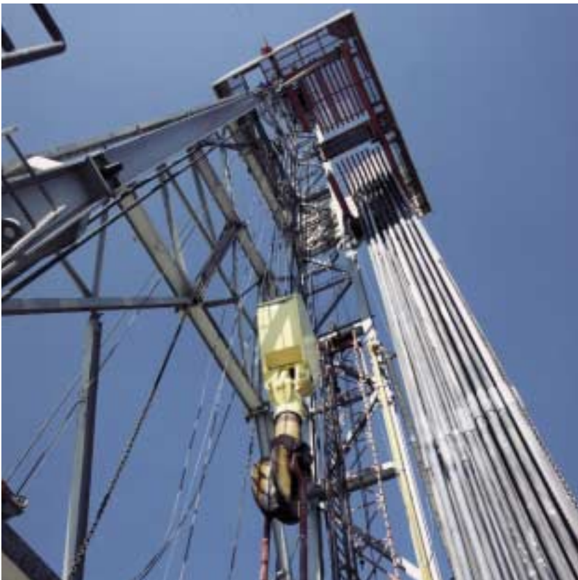
Blick in einen Bohrturm
