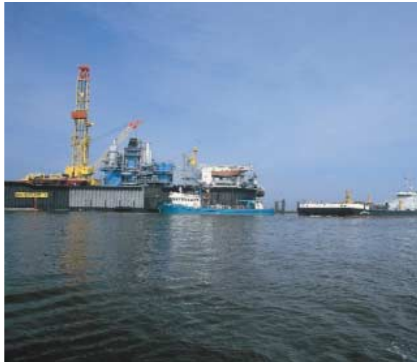
Bohr- und Förderinsel Mittelplate
