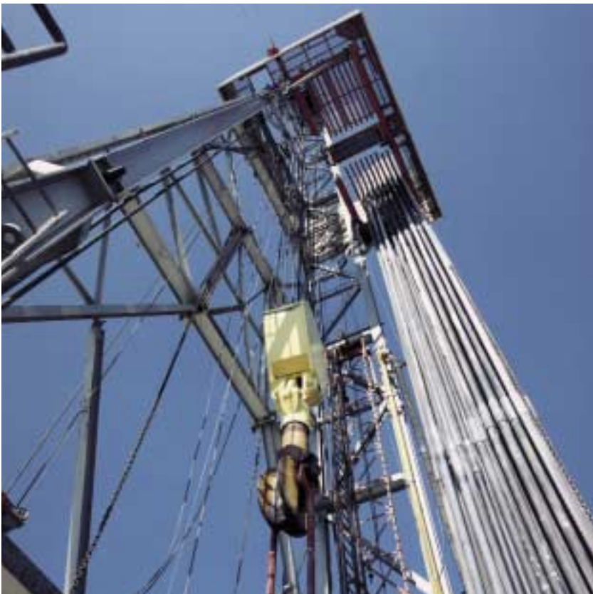
Blick in einen Bohrturm
