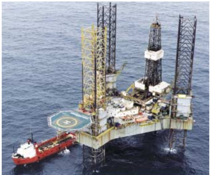
Bohrarbeiten in der deutschen Nordsee
