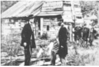
Suche nach dem schwarzen Gold: die erste Bohrung in Pennsylvania
