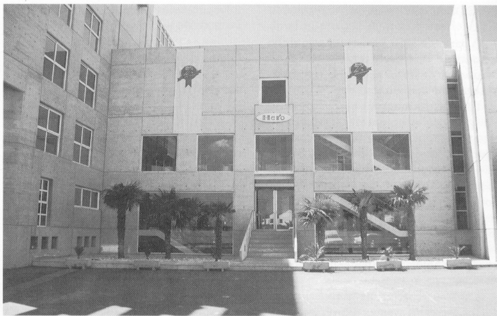
Fachada de la entrada al edificio de oficinas y Admón.
